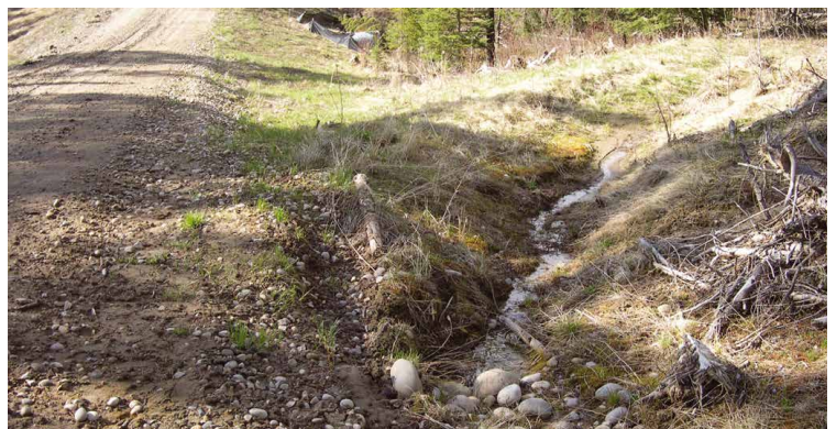
Photo 2 : Barrage de retenue et saignées
