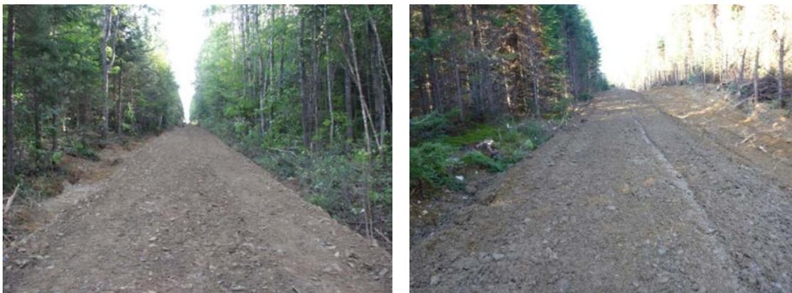
**Figure 3. Surface finale de la route, telle qu'exécutée par la Kobelco BladeRunner ED150 (gauche) et le système excavatrice-bulldozer (droite)**
