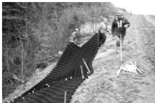
Figure 5. (à gauche) Déploiement du panneau Geoweb.
