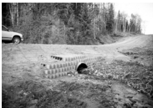
Figure 4. Muret de soutènement complété.
