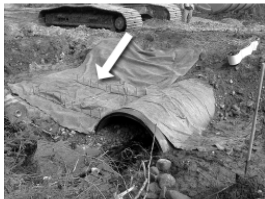
Figure 2. (à gauche) Préparation du site pour l'installation; le cadre d'étirement du Geoweb est visible à gauche (flèche).
