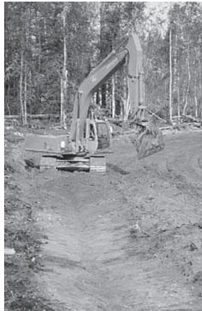
Figure 5. Creusage de fossés par l'excavatrice à l'aide d'une lame de formage.
