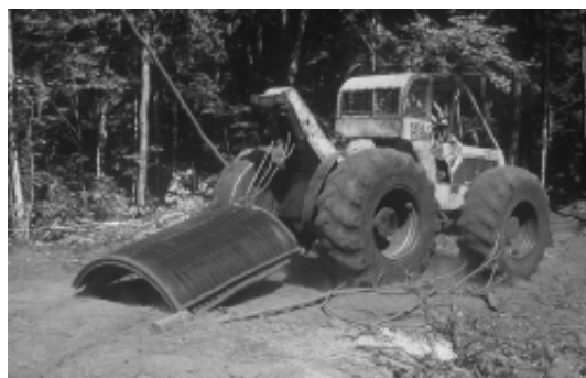
Figure 1. La robuste arche de plastique KWH peut facilement être transportée jusqu'au site d'installation.
