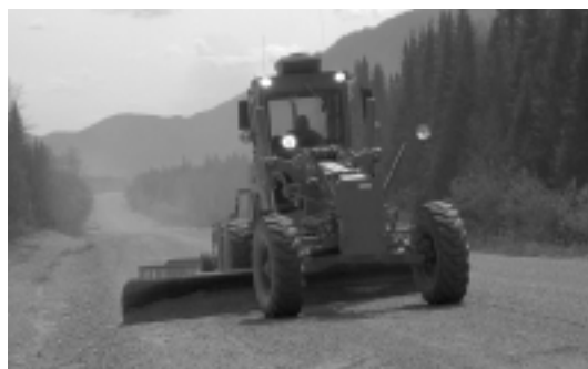
Figure 1. Le nivelage sur une route forestière.
