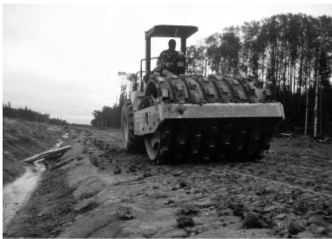
Figure 1. Compacteur de 10 t à pieds de mouton utilisé sur la route à fossé en V.
