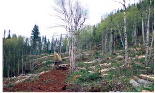
**Figure A5.** Construction d'un sentier avec une pelle mécanique dans un terrain à pente forte dans le centre de Terre-Neuve.
