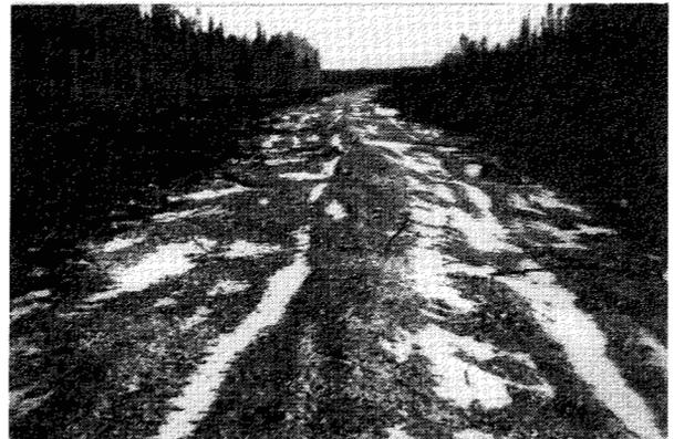
Figure 1. L'épaisseur du matelas de copeaux dépend du volume de matière ligneuse disponible sur le site de construction.
