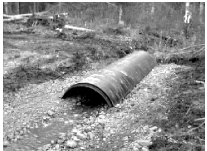
Figure 1. La première section de 6 m de l'arche en place.
