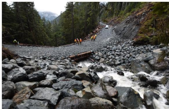
**Figure 1.** Dans certains cas, les ponts à fleur d'eau et les passages à gué peuvent être envisagés lorsqu'ils permettent le passage des hautes eaux, des gros débris et des sédiments par-dessus la structure avec un minimum de dommages.
