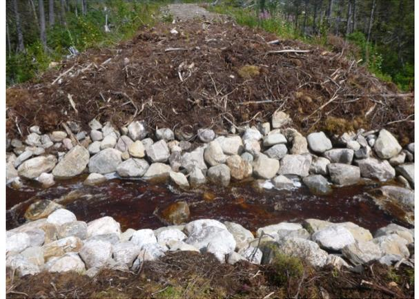
**Figure 2. Le retrait des traverses de cours d'eau peut réduire les coûts d'entretien futurs et les impacts sur l'habitat aquatique de la défaillance de ces structures.**
