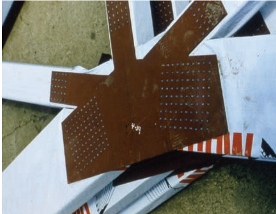
Figure 4. Les rivets à lamellé-collé utilisés avec le bois de fortes dimensions
