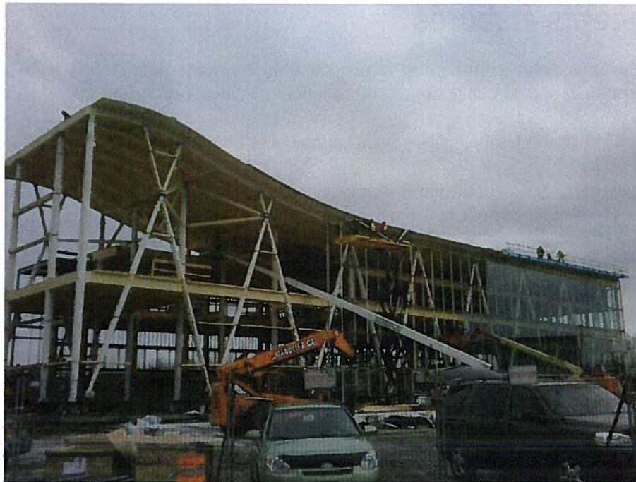
Figure 3 Colonnes inclinées à 45 degrés
