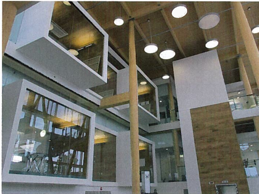
Figure 2 Colonnes à diamètre variable
