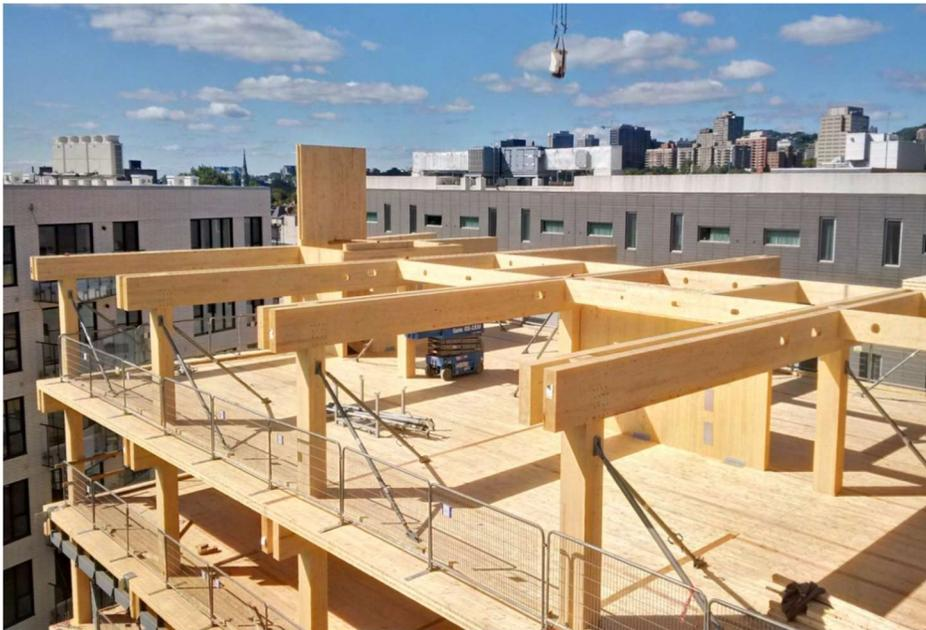
**Figure 2. Planchers en CLT appuyés sur des poutres dans une construction à poutres et poteaux**
