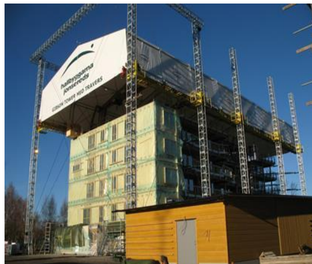
Figure 5. Utilisation d'une toiture amovible temporaire pour protéger une construction en bois en Suède
