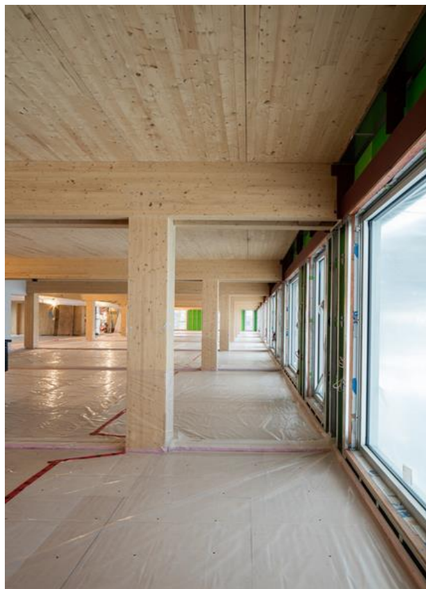
Figure 4. Plancher rendu étanche à l'aide de feuilles de plastique dans un bâtiment en bois à Montréal
