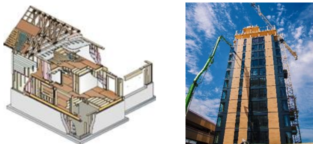
Figure 1. Évolution de la construction, de la maison classique en bois de charpente construite par des charpentiers-menuisiers (A) aux immeubles de grande hauteur réalisés en bois massif, comme le montre un immeuble en bois massif de 18 étages à The University of British Columbia, à Vancouver (B).
